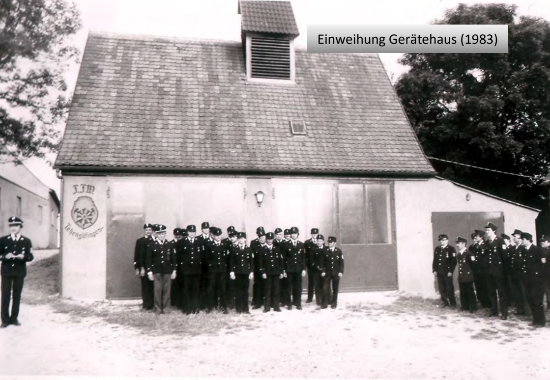
Lehengütinger Feuerwehr vor ihrem neuen Gerätehaus.
